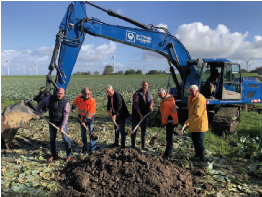
Spatenstich Neuer Radweg - 5.10.2023 (Foto C. Looft)
